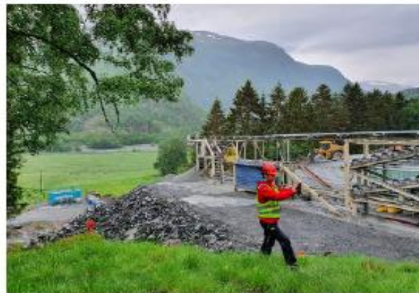
Bilde 2: Riggplassen er bygget ut fra opprinnelig terreng.
