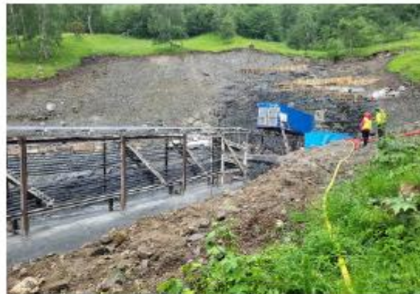
Bilde 1: Tunellpåhugg med riggplass i forkant.
