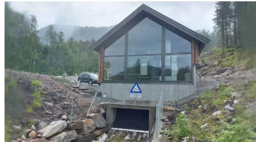
Stølselva kraftverk ligger i Sunnfjord kommune | Foto: Småkraft
